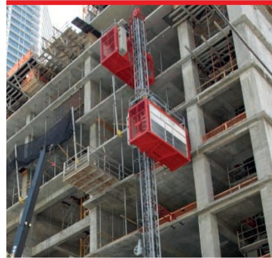
Строительные подъемники используются при строительстве с высокими требованиями к транспортировке пассажиров и материала, на стройках высотных зданий и мостовых опор. Подъемники спроектированы и изготовлены, чтобы работали длительно и надежно. Подъемник поставляется также в исполнении ДУО (две кабины на одной мачте).
