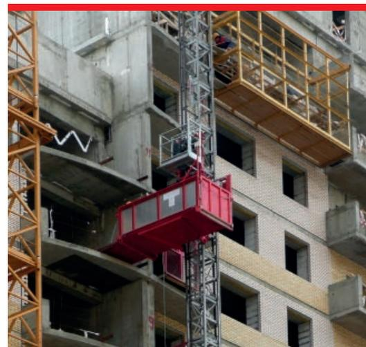
Грузовые подъемники используются при строительстве с высокими требованиями к транспортировке материала, на стройках высотных зданий, мостовых опор. Подъемники сконструированы и изготовлены, чтобы работали длительно и надежно. Длина кабины подъемника предусмотрена с 3 000 мм до 3 800 мм.
