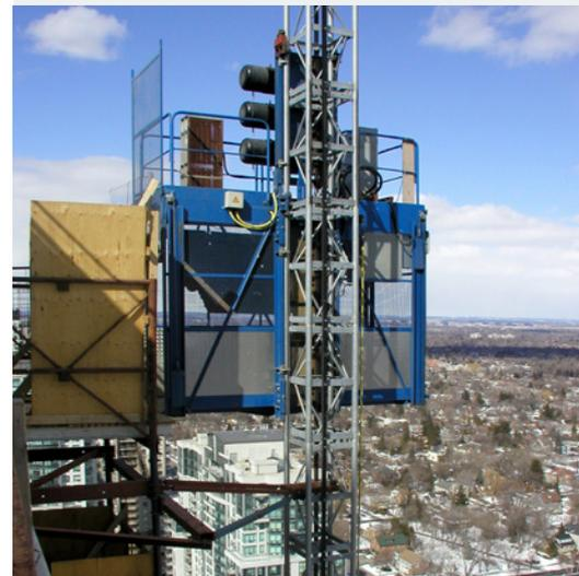
Строительные подъемники используются при строительстве с высокими требованиями к транспортировке пассажиров и материала, на стройках высотных зданий и мостовых опор. Подъемники спроектированы и изготовлены, чтобы работали длительно и надежно.
